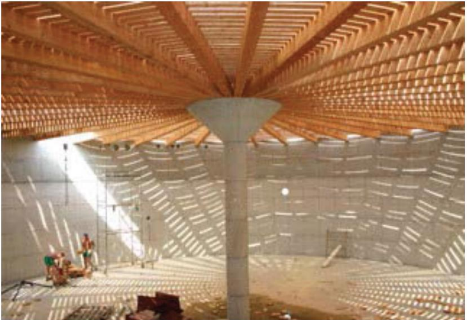
Digestore monostadio 1.000 kWe – interno (Rota Guido)
