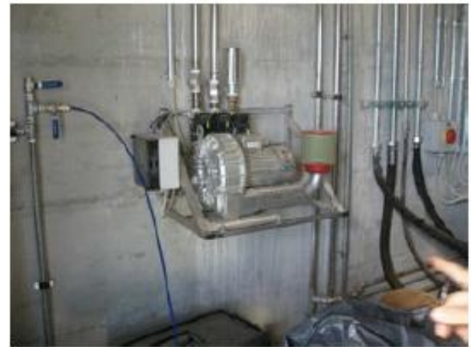
Soffiante desolforazione
