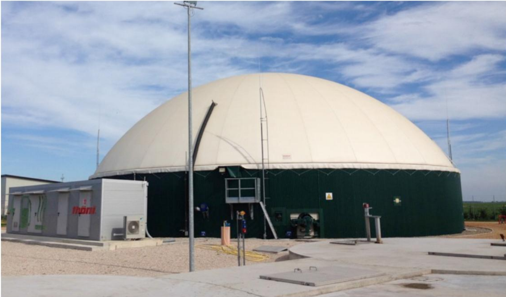
Digestore verticale monostadio 300 kWe
