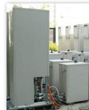
**MCI 1kW<sub>e</sub>, 2,8 kW<sub>t</sub>,  $\eta_e$  22,5%,  $\eta_t$  63%**
