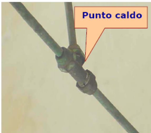
Foto visiva del particolare
